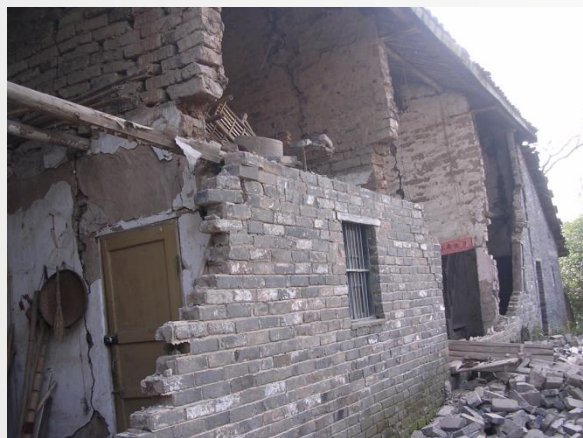
砖土混砌墙体的震害（九江地震）
