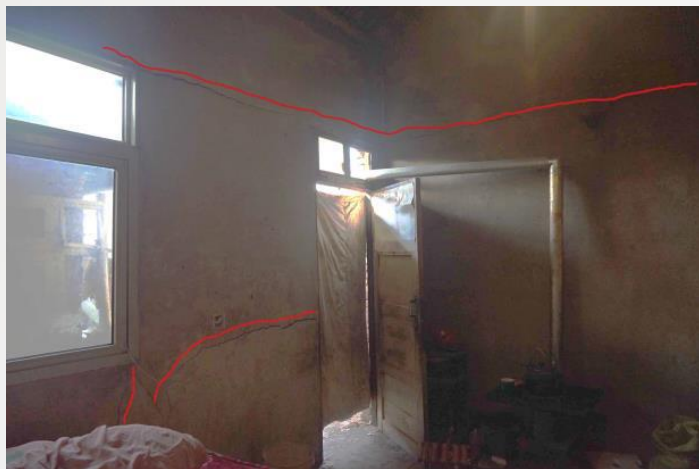
不均匀沉降引起的拉裂裂缝
