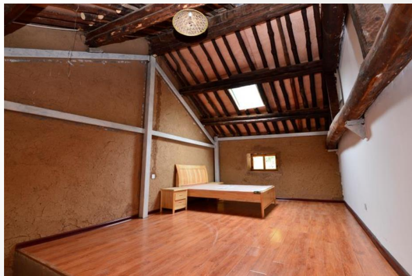
陕西蓝田、大荔 轻钢小框架内支撑 加固生土墙体 结合建筑改造梳理功能空间
