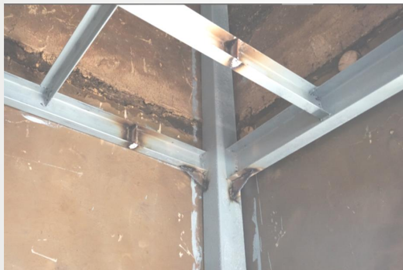
陕西蓝田、大荔 轻钢小框架内支撑 加固生土墙体 结合建筑改造梳理功能空间
