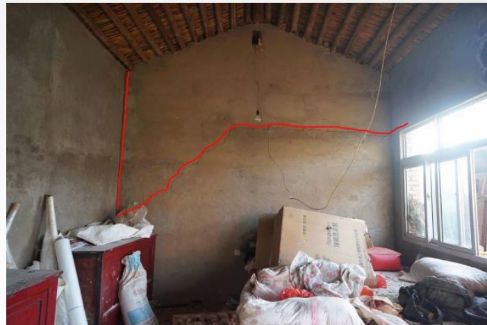
不均匀沉降引起的拉裂裂缝
