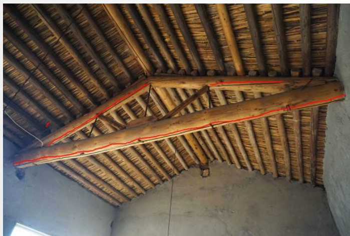
不均匀沉降引起的拉裂裂缝
