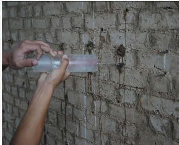
注浆修补裂缝，拆除墙体时修补处粘结良好
