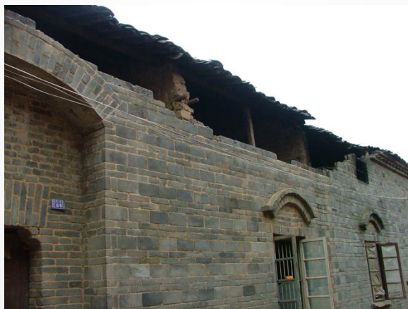
砖土混砌墙体的震害（九江地震）
