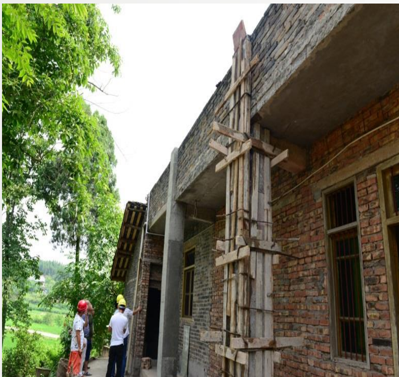
砖柱配筋包角增大截面加固 改善原砖柱强度不足和截面过小的问题
