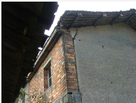
不同材质混砌的墙体，采用直槎砌筑的墙体，交接处通缝，墙体整体性差
