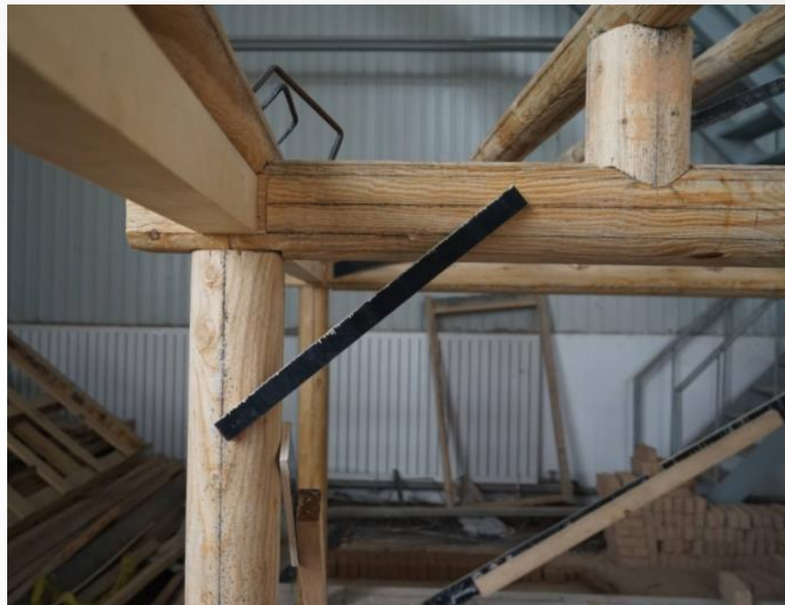
抬梁式木构架加设斜撑
