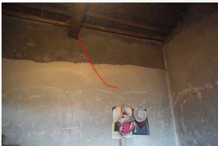
不均匀沉降引起的拉裂裂缝
