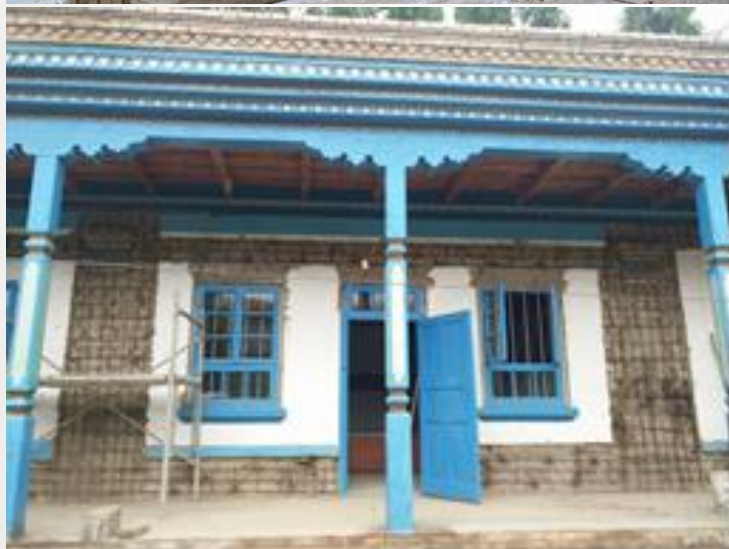
配筋砂浆带加固生土墙体 (新疆特克斯县木构架生土墙房屋加固)
