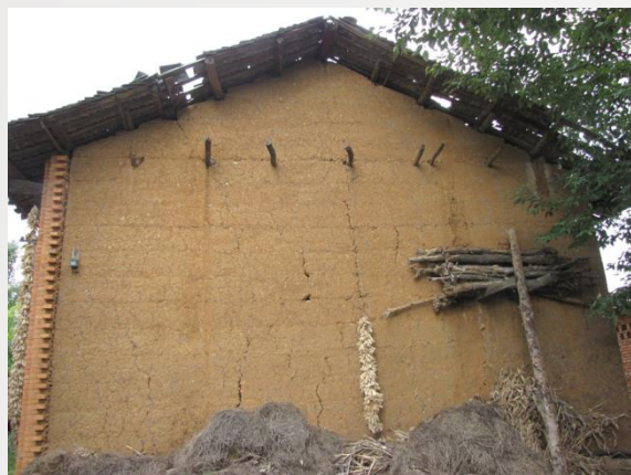
不同材质混砌的墙体，采用直槎砌筑的墙体，交接处通缝，墙体整体性差
