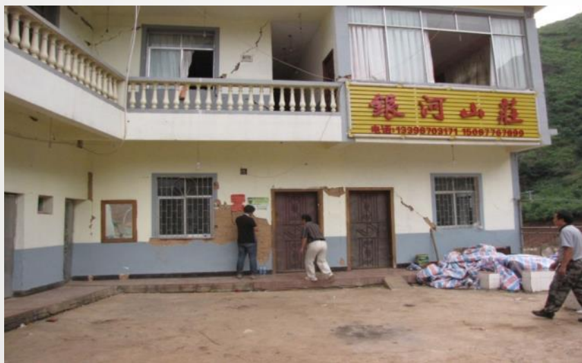
鲁甸地震的9度区，砌筑砂浆强度与房屋震害程度直接相关
