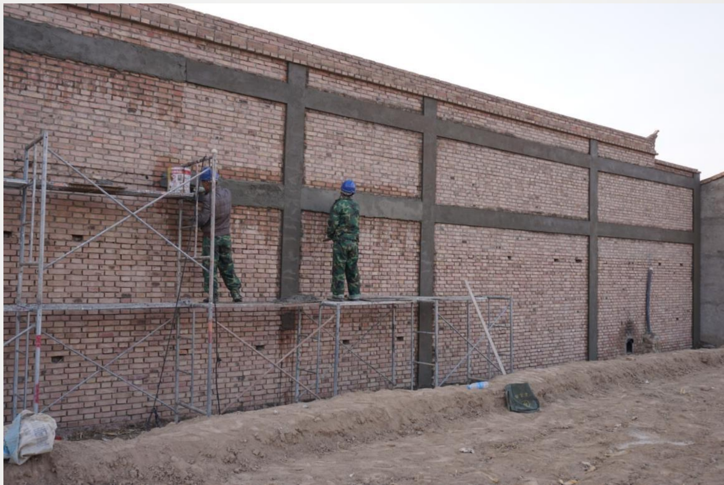
水平、竖向设置双侧砂浆配筋带加固砖墙（甘肃临洮）
