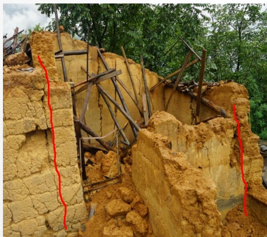
鲁甸地震生土墙承重房屋在地震中倒塌
