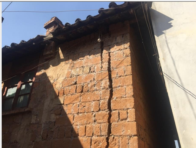
围护墙 局部倒塌
