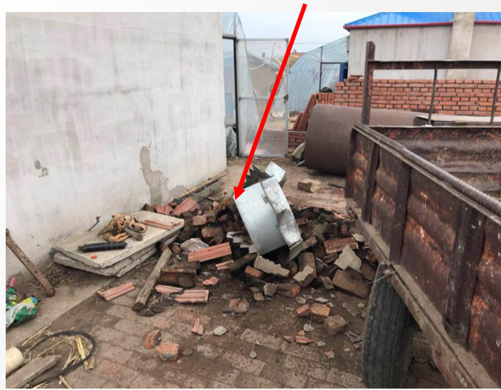
无拉结烟囱倒塌掉落
