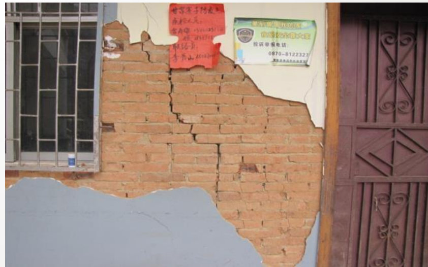
鲁甸地震的9度区，砌筑砂浆强度与房屋震害程度直接相关
