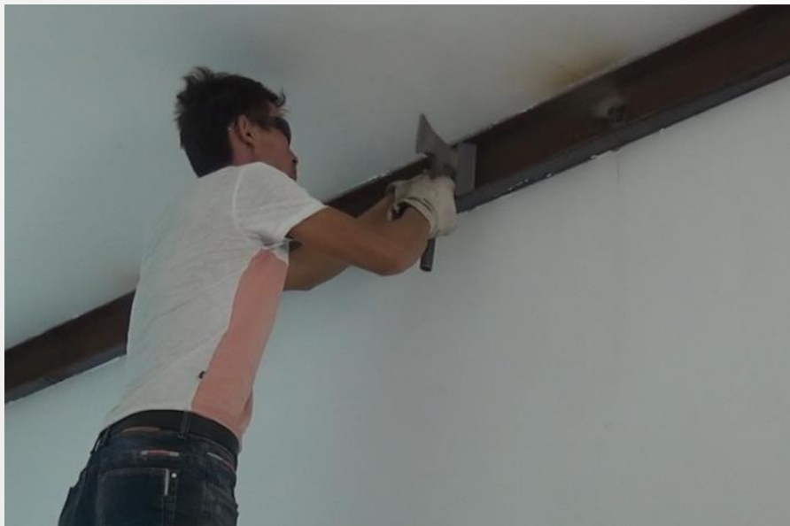
预制板底增设槽钢加固 同时起到圈梁作用
